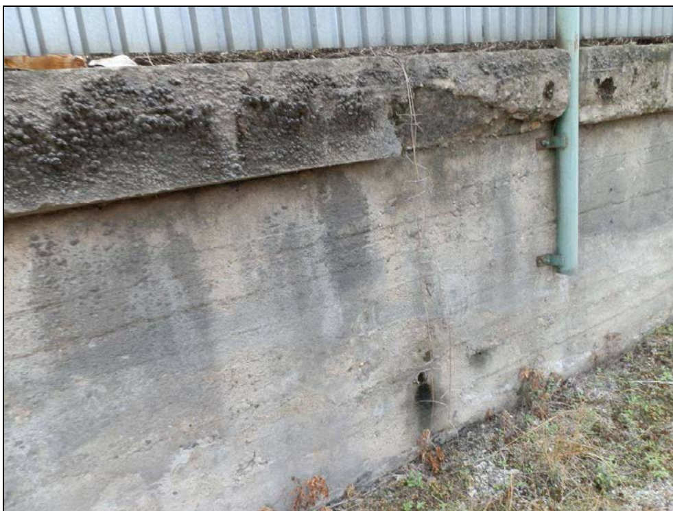
Obr. č. 5 - vypadlý kus římsy, degradovaný beton římsy.
