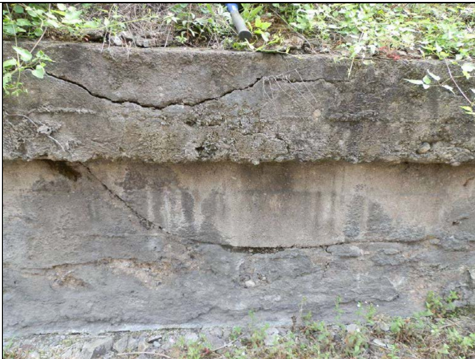
Obr. č. 6 - stav opěrné zdi ve snižené části v km cca 40,480. V okolí pracovních spár opadává povrch betonu a prosakuje voda.
