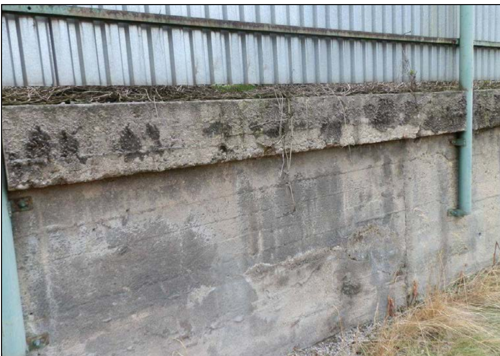
Obr. č. 3 - typický současný stav dříku opěrné zdi. Beton římsy je poškozený a místy vypadává do hloubky 10 - 70 mm. Beton dříku je celoplošně degradovaný, s proměnlivým obsahem pojiva, lokálně jsou stopy po prosakující vodě.
