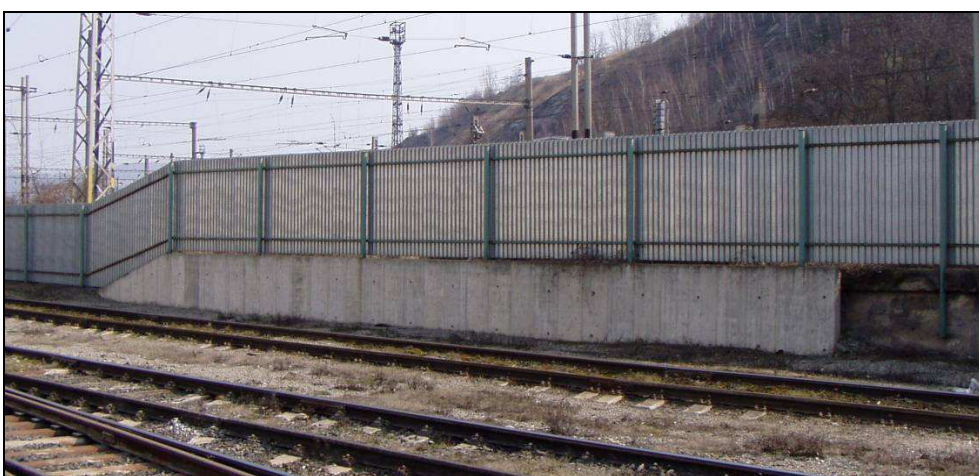
Obr. č. 2 - nová opěrná zeď na začátku úseku
